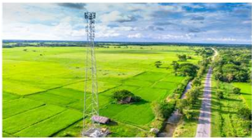
Телекоммуникационные башни - бизнес
